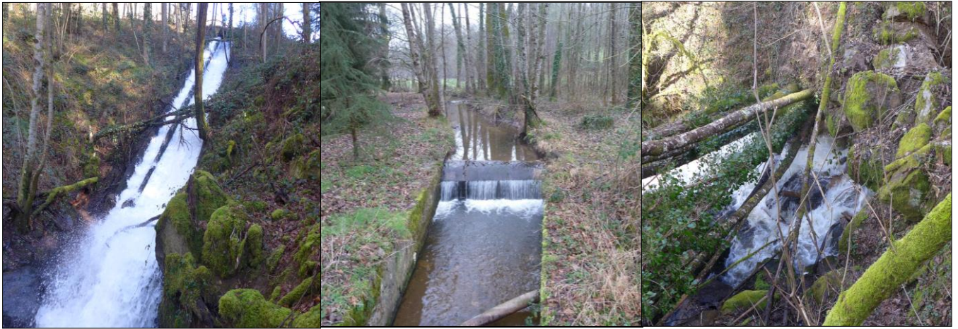
Figure n°6 : Photos de 3 des 4 franchissements de l'aval du bassin vue depuis l'aval, (de gauche à droite, le site 5, 9 et 7), cliché Biotec 2015.
