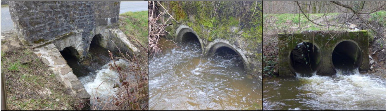
Figure n°4 : Photos de 3 des 4 franchissements de l'amont du bassin vue depuis l'aval, (de gauche à droite, le site 2, 3 et 4), cliché Biotec 2015.
